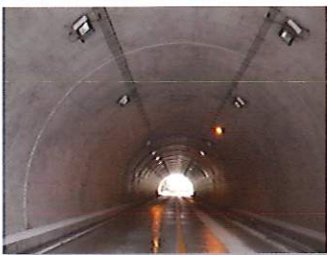
トンネル覆工
