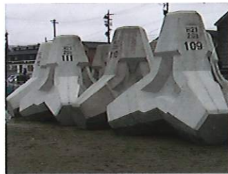
波消ブロック
